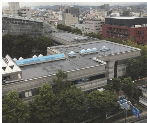
検証し、8月に配置を改善。陰の影響を放置すると、発電量が減るのみでなく電気抵抗による発熱でモジュール自身が損傷する原因になります。継続的で丁寧な発電状況の把握・検証が不具合の回避や早期発見につながることを痛感、ヒトの体と一緒にですね。
