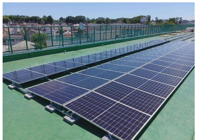
“光害”や風の影響を防ぐために、パネルの傾斜が少ない施工としている。
